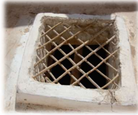
شكل (22) شكل الفتحة الخارجة الموجودة في أسطح المباني [19]
